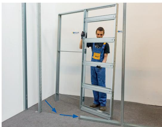
6/ Das Einsetzen der System-Schiebetürbox erfolgt entweder in die vorgegebene Öffnung oder im linearen Bauablauf der Ständerwand. Die Box lässt sich passgenau in das U-Bodenprofil einsetzen, und steht damit geradlinig im Wandverlauf.
