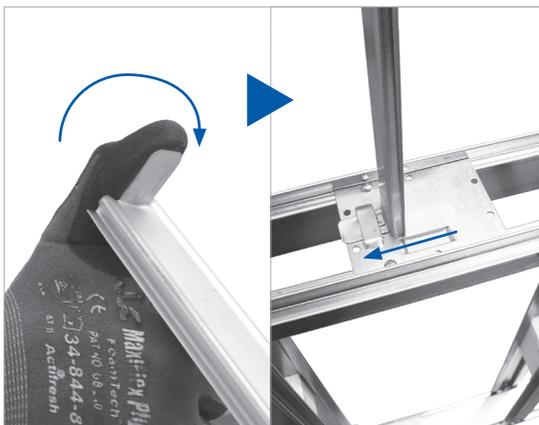
4/ Setzen Sie die Distanzhalter in die dafür vorgesehenen Distanzhalterplättchen mittig und unten im Einschubbereich des Schiebetürkastens. Je nach Profilstärke des Schiebetürkastens sind die Distanzhalterplättchen unterschiedlich befestigt.
