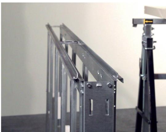
2/ Nach Öffnen der Verpackung: Lösen Sie die beiden Schrauben bei der Bajonettverzahnung.
