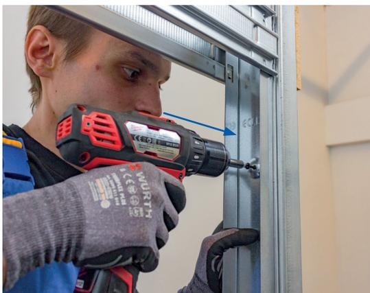
8/ Auch das hintere Profil wird durch die dafür vorgesehenen Löcher bequem mit dem Ständerwerk verschraubt.
