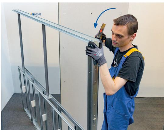
5/ Im nächsten Schritt wird das Anschlagprofil in Laufschieneneinheit und Distanzhalter eingesetzt und die Metalllaschen zur Befestigung umgeschlagen. Damit ist die Eclisse System-Schiebetürbox vorbereitet zum Einsetzen in die Ständerwand.
