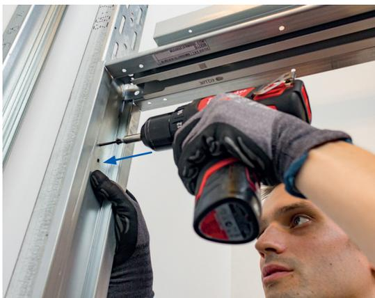
7/ Nun erfolgt die Fixierung der Box mit dem Ständerwerk. Das systemeigene Anschlagprofil mit Meterriss ist robust ausgeführt und hat eine mittige Vertiefung, so dass später die bauseitigen Fixierschrauben nicht mit der Verkleidung „kollidieren“.
