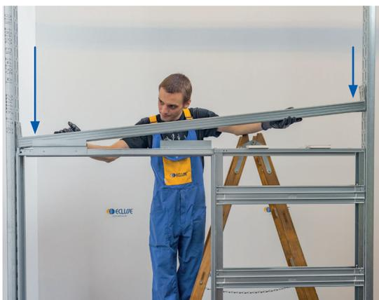
9/ Als letzter Teil der Einbindung der Systembox in das Ständerwerk erfolgt der obere Anschluss. Hier stehen im Lieferumfang Zentrierungswinkel zur Verfügung, die sicherstellen, dass das obere Profil geradlinig über den Schiebetürkästen geführt werden kann.
