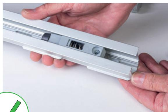
**4** Bauen Sie die Laufschiene wieder in den Schiebetürkasten ein. Durch das Langloch am Ende der Zunge können Sie durch Verschieben der Zunge alle Schrauben der Laufschiene wieder befestigen.
